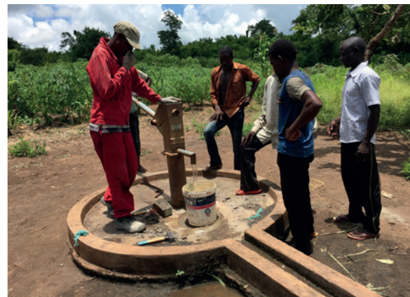
Reparatur eines «Fontanário»
