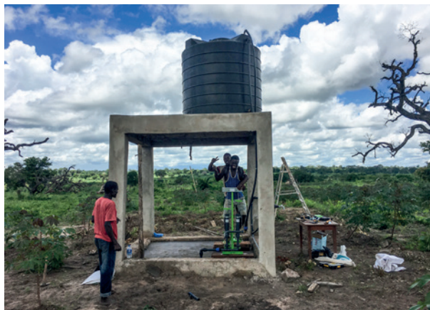
Kleinwasserversorgung im Bau
