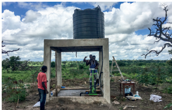
Petit puits d'approvisionnement en construction
