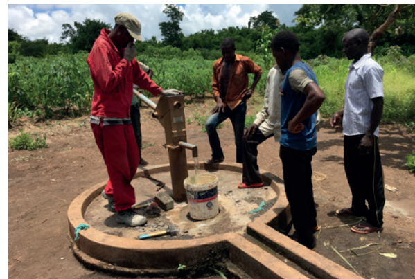
Réparation d'un « Fontanário »
